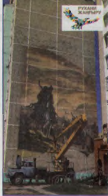
На доме 6-43 уже ведутся работы
