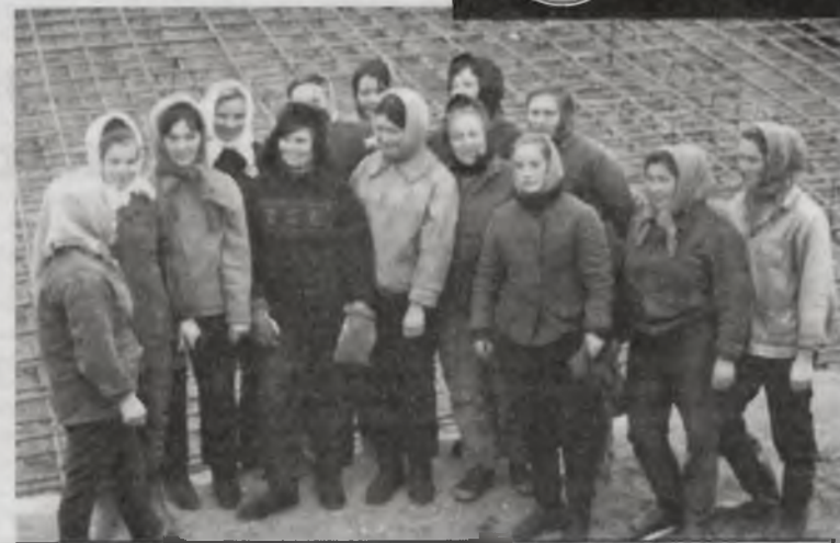
Строительство Верхнетобольского гидроузла. Бригада сварщиков. 1967 год.
