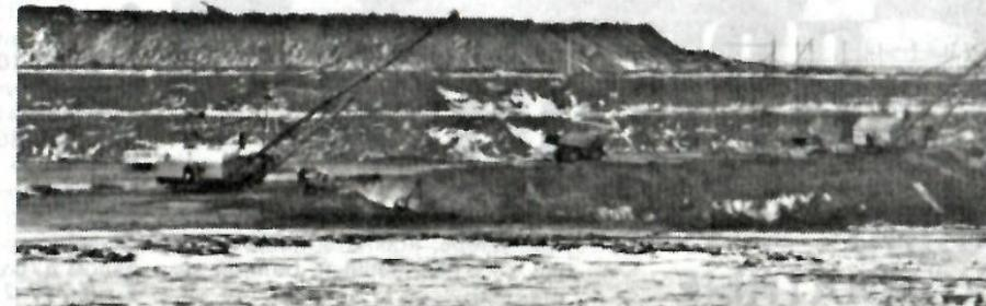
Насосная станция, водоотвод, линия электропередачи, столбы для освещения - все уже готово. Работают там два экскаватора, четыре автосамосвала, бульдозер и автогрейдер. Запасы боксита составляют 1 млн 189 тыс. тонн. Проектные размеры карьера: длина - 700, ширина - 600, глубина - 119 метров. В январе здесь запланированы взрывные работы, после
