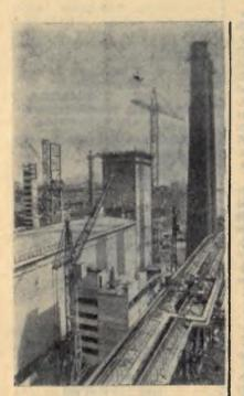
область. Челябинская Ha Магнитогорском металлургичес ком комбинате имени В. И. Леинна сооружается важнейший пусковой объект 1981 года-коксовая батарея № 8-бис (на снимке). Она сменит старую батарею. проработавшую около 50 лет. Строительство идет полным ходом. Кладку почти 20 тысяч огнеупоров 800 различных марок выполняют специалисты, приехавине на Магнитку на Кузбасса, Липецка, Караганды.
