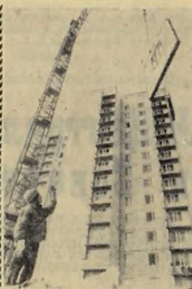
Москва. Монтаж шестнадцатизэтажного жилого дома, сооружаемого ДСК-1 в Медведково идет по графику: два дня — и этаж готов. Такой рекордный ритм взят бригадой КММУ-5, возглавляемой заслуженным строителем РСФСР коммунистом Анатолием Суровцевым. Лег-
