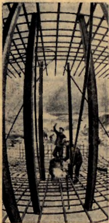
На реке Вахш сооружается Байпазникская ГЭС мощностью 600 тысяч киловатт.
