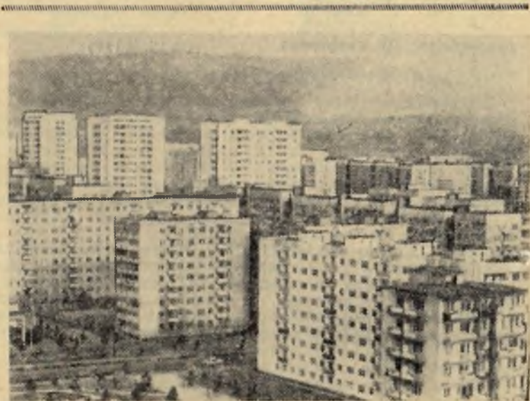
«Граждане СССР имеют право на жилище». (Из статьи 44 Конституции СССР).
