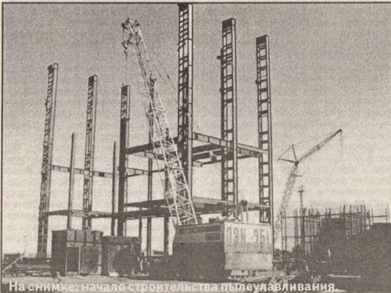
На снимке: начало строительства пылеулавливания.
